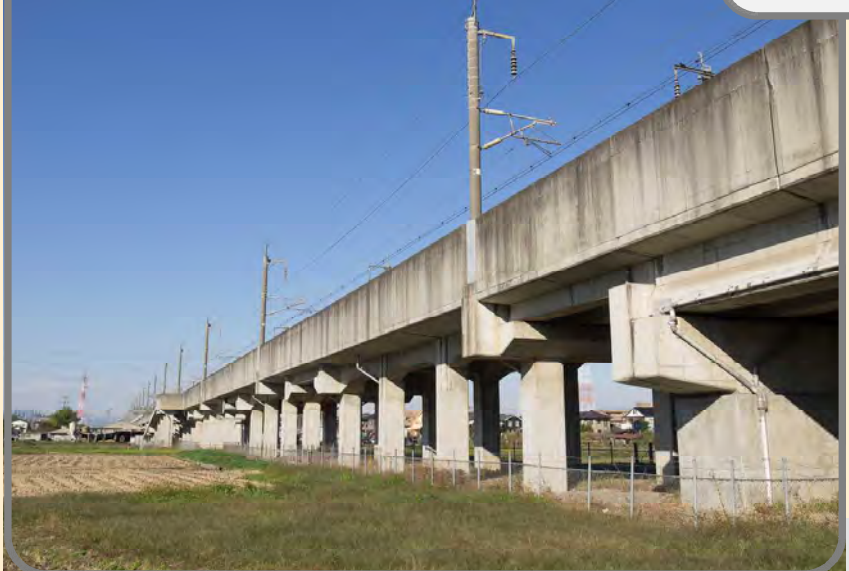
図2. 新幹線高架の隙間
