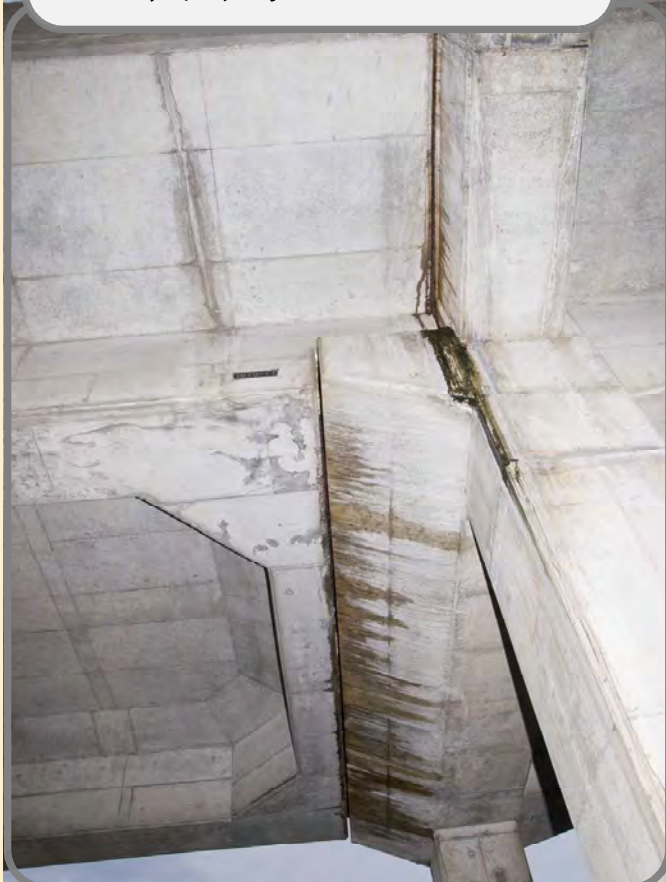
図2. 新幹線高架の隙間
